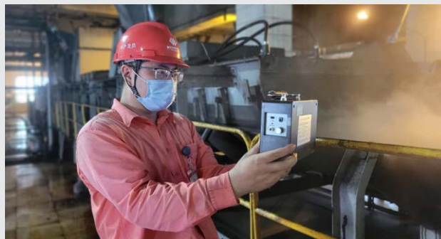
燃料人員測量干霧抑塵裝置啟動後環境粉塵濃度
