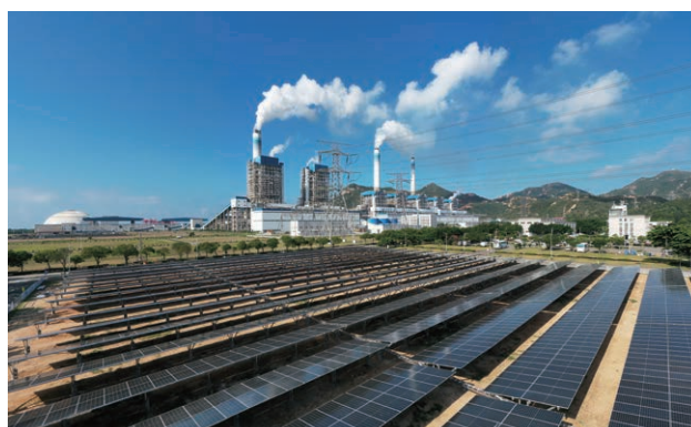
台山電力分佈式光伏項目
