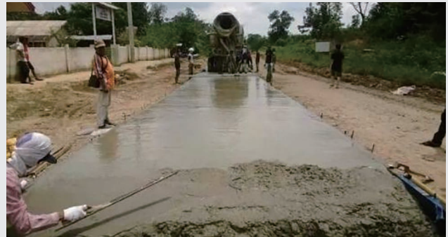
幫助硬化周邊村中主幹道
